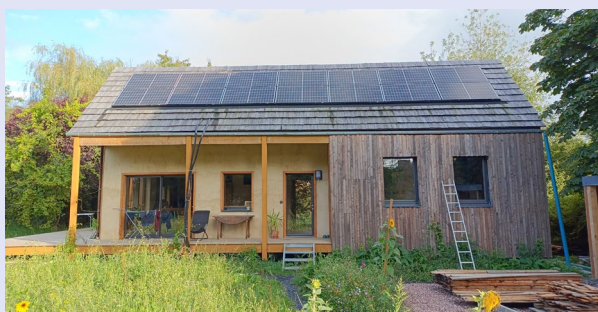
Bâtiment commun dans le hameau réversible du Placis à Saint-André-des-Eaux (22).
